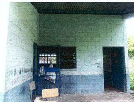
APLICACIÓN DE PINTURA EN AULA, DIRECCION Y CORREDOR
