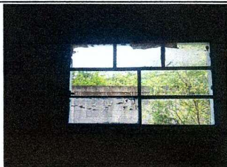
COLOCACIÓN DE VIDRIOS DAÑADOS
