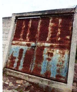
MANTENIMIENTO DE PORTÓN 3X2 CAMBIO DE CHAPA LIJADO Y PINTADO
