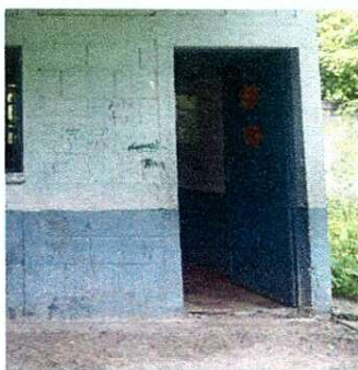
SUSTITUCIÓN DE PUERTA DE METAL 2X1
