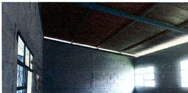
SUSTITUCIÓN DE PINTURA EN LAMINAS Y ESTRUCTURA
