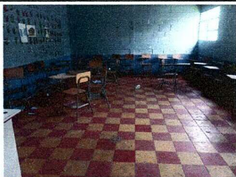
SUSTITUCIÓN DE PISO POR PISO CERÁMICO
