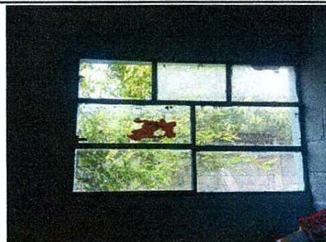
MANTENIMIENTO DE VENTANAS DE 1.65X1.00 MTS.
