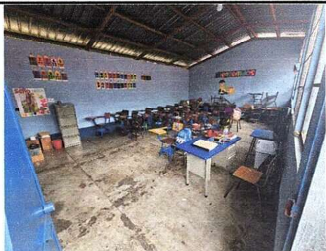
Foto 1: Sustitución de piso de concreto aula 1
