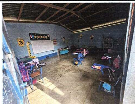
Foto 2: Sustitución de piso concreto aula 2
