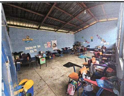
Foto 3: Sustitución de piso de concreto en aula 3
