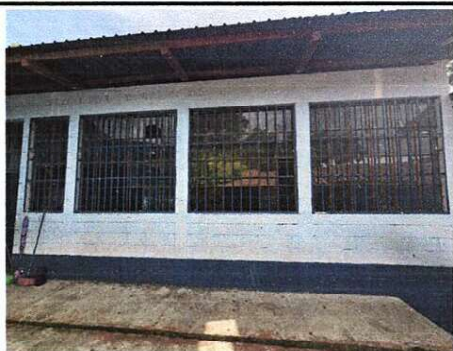
Foto 5: Sustitución de estructura de metal de 4 ventanas y mantenimiento a balcones de metal
