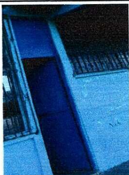
MANTENIMIENTO DE PUERTA DE METAL LIJADO Y PINTADO
