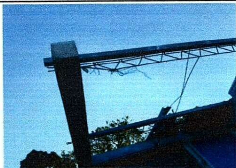
SUSTITUCION DE LÁMINA TROQUELADA
