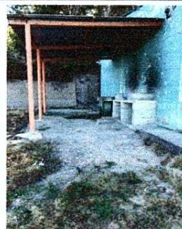
FABRICACIÓN DE PISO TORTA EN GALERA
