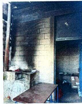
DEMOLER BANO DE PUERTA
