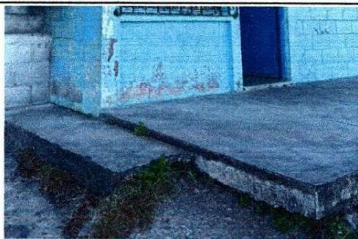
REPARACIÓN DE BANQUETA O CERA
