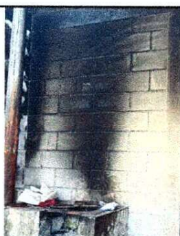
DEMOLICIÓN DE PARED Y SACADO DE RIPIO
