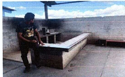
Foto 4: Reconstrucción de desayunoador de 2x2 con depósitos block y azulejo
