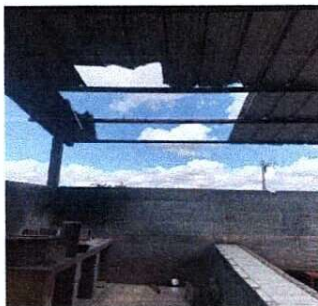
Foto 5: Levantado de block 20x40x15 hierro 3/8 @20 +estribo 1/4
