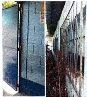
Foto 4: Remozamiento Puertas y Balcones
