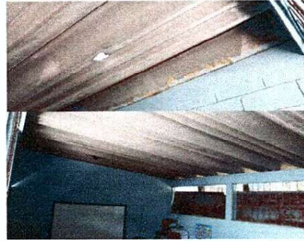
Foto 2: Aulas: Colocación de estructura metálica, se hará un remozamiento de puertas y balcones incluyendo la pintura de los mismos, y se pintara todas las aulas del modulo por el lado exterior
