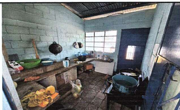
Foto 3: Sustitucion de puertas, sustitucion de piso de granito, reparacion o sustitucion de azulejos
