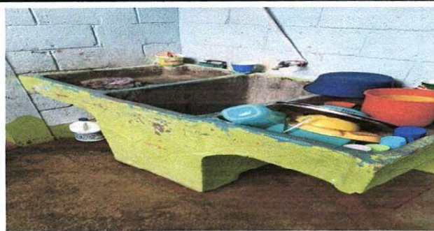
Foto 5: Sustitucion e instalacion de pila de cemento de dos lavaderos
