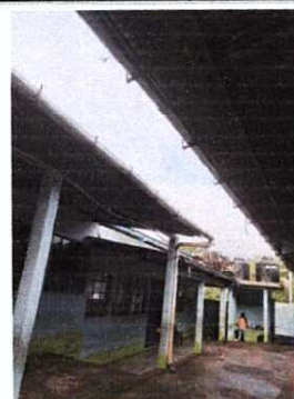
Foto 10: Sustrucción de reposadera, sustitución de tubería línea principal, reparación de planchas de concreto de patio, sustitución de canal de metal, reparación de agua pluvial
