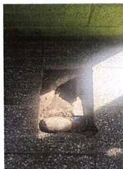
Foto 9: Reparación de tapadera de caja
