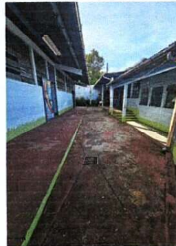
Foto 8: Sustrucción de reposadera, sustitución de tubería línea principal, reparación de planchas de concreto de patio, sustitución de canal de metal, reparación de agua pluvial
