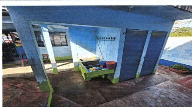
Foto 6: Sustitucion e instalacion de inodoros, sustitucion e instalacion de puertas en sanitarios, sustitucion de mingitotio, sustitucion de llaves de paso.
