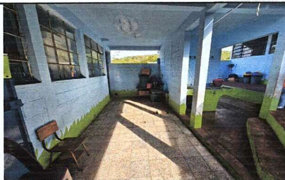
Foto 4: Fabricacion e instalacion de ventana, sustitucion e instalacion de lavamanos, manteniminto reposadera
