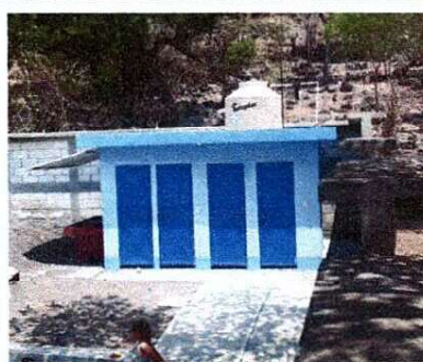
Foto 8: Mantenimiento del sistema hidráulico de baños
