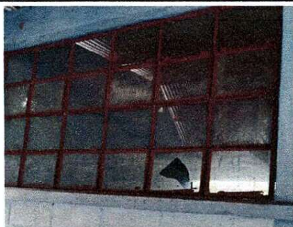
Foto 5: Cambio de Vidrios Quebrados
