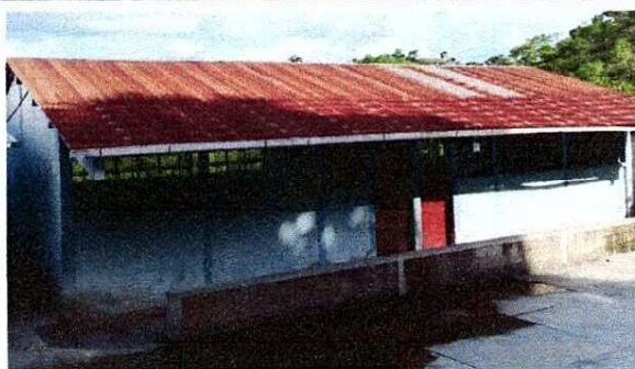
Foto1: Sustitución de lámina por lámina troquelada
