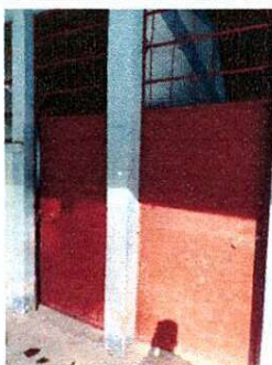
Foto 7: Mantenimiento de Puertas con Cerradura: lijadas y pintadas 2x1
