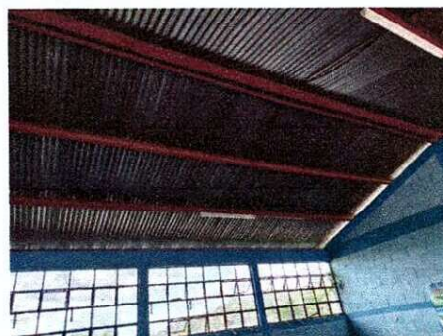
Foto 2: Mantenimiento de estructura metálica lijado y pintado
