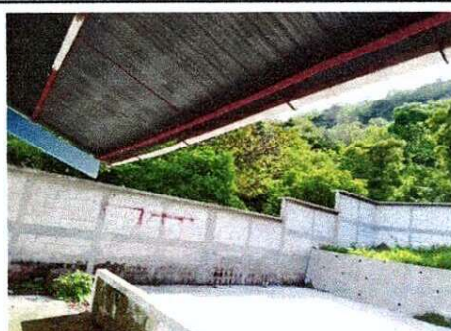
Foto 4: Sustitución de canal de metal
