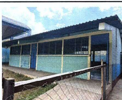
Foto 8: PINTURA GENERAL DE AULAS
