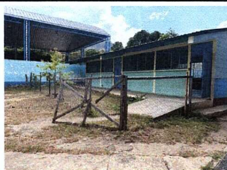
Foto 7: MEJORAMIENTO MURO PERIMETRAL
