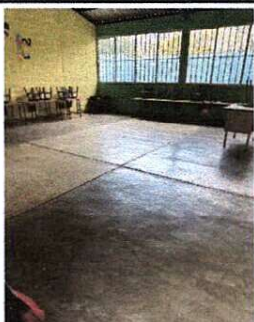
Foto 5: INSTALACION DE PISO INTERIOR AULA 1
