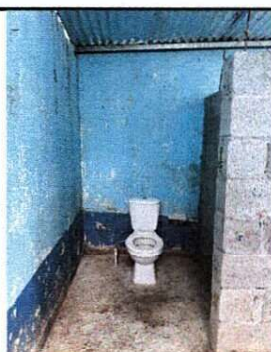
Foto 7: MEJORAMIENTO SERVICIOS SANITARIOS
