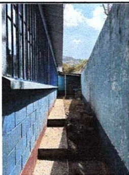
Foto 1: INSTALACION DE TECHO METALICO
