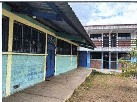
Foto 7: MANTENIMIENTO DE PUERTAS
