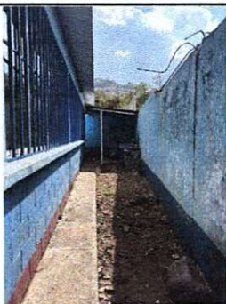
Foto 3: FUNDICION PISO DE CONCRETO
