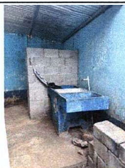
Foto 4: SUSTITUCION DE PILA
