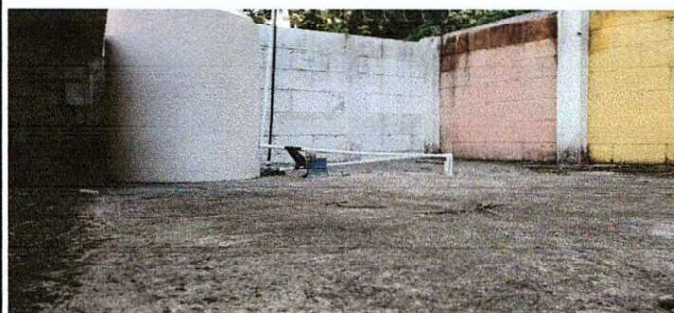
Foto 3: Cambio y reordenamiento de tubería.
