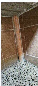
Foto 5: Resanado de interior de pila por fuga existente.
