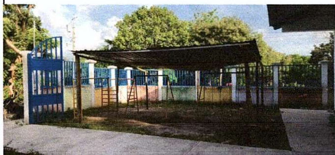
Foto 1: Mejoramiento galera de estructura metálica con lámina calibre 26 y una losa de concreto de 5 cms de espesor.
