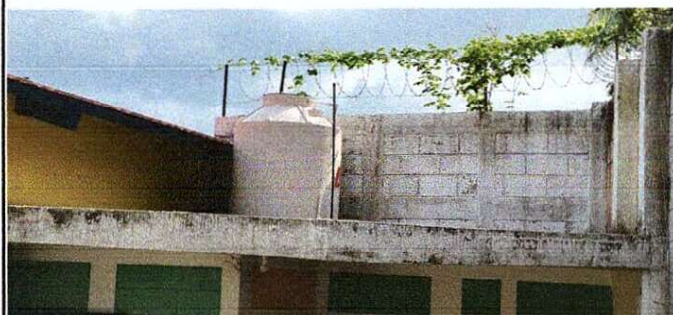
Foto 2: Tinaco existente, se elevará por medio de una base hecha por estructura metálica a 1 mt de altura.
