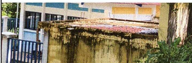
Foto 4: Resanado de losa por filtraciones y colocar salidas pluviales para evitar el estancamiento.
