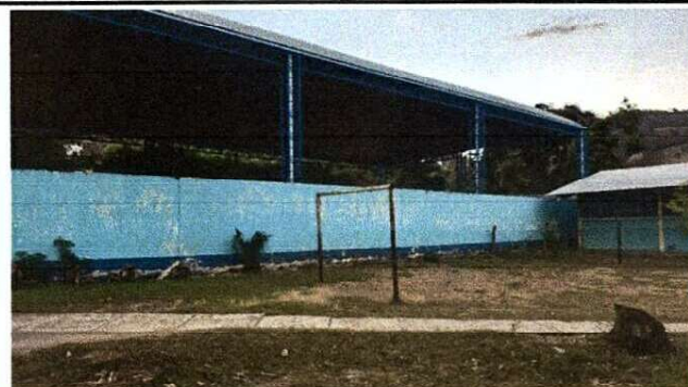
Foto 2: : INSTALACION DE ESTRUCTURA METALICA, ELECTROMALLA Y RAZOR COMO MEDIDA DE SEGURIDAD
