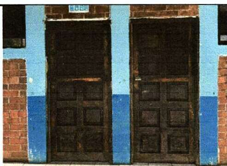
Foto 5: SUSTITUCION DE PUERTAS
