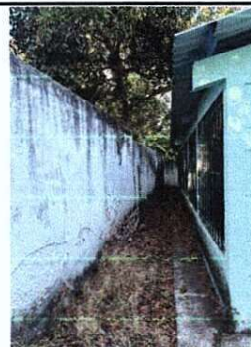
Foto 8: PINTURA EN MURO PERIMETAL
