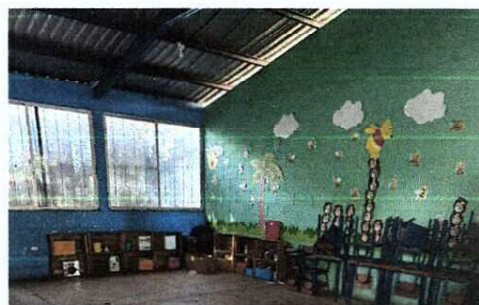
Foto 12: PINTURA DE AULAS
