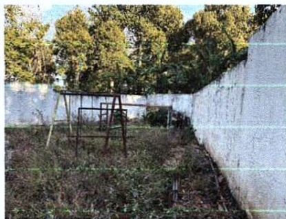
Foto 7: PINTURA EN MURO PERIMETAL
