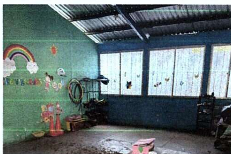
Foto 11: PINTURA DE AULAS
