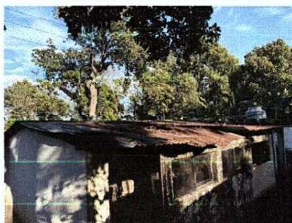
Foto 9: SUSTITUCION DE TECHO EN COCINA
