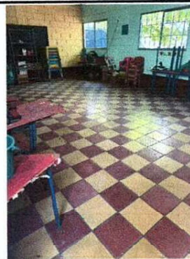
Foto 4: MODULO 1: INSTALACION DE PISO CERAMICO AULA 1, PINTURA GENERAL, INSTALACION DE MALLA EN ALEROS.
