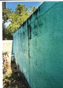
Foto 8: MURO PERIMETRAL: LIMPIEZA Y PINTURA GENERAL
