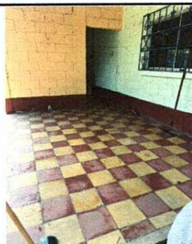
Foto 5: MODULO 1: INSTALACION DE PISO CERAMICO DIRECCION Y CORREDOR, PINTURA GENERAL, INSTALACION DE MALLA EN ALEROS.
