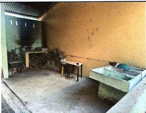
Foto1: MODULO DE COCINA: REPARACIÓN DE ESTUFA RURAL Y MUEBLE BAJO FUNDIDO, AZULEJO, PINTURA GENERAL, INSTALACIONES HIDROSANITARIAS, INSTALACION ELECTRICA, PISO, PILA.
