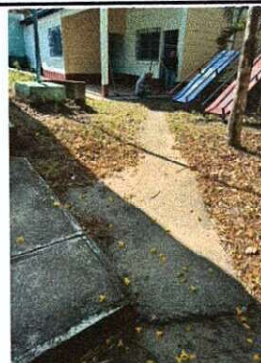
Foto 10: CAMINAMIENTOS: FUNDICION DE PLANCHA DE CONCRETO DE 0.075 M.
