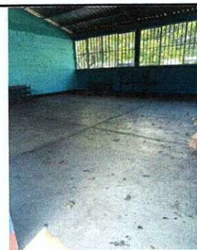
Foto 6: MODULO 2: INSTALACION DE PISO CERAMICO AULA 2, PINTURA GENERAL, INSTALACION DE MALLA EN ALEROS.
