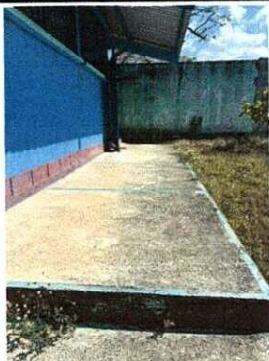
Foto 7: MODULO 2: INSTALACION DE PISO CERAMICO CORREDOR, PINTURA GENERAL, INSTALACION DE MALLA EN ALEROS.
