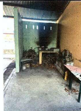
Foto2: MODULO DE COCINA: SUSTITUCION DE COSTANERAS EN TECHO.
