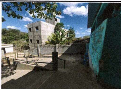
Foto 5: Remoción de pasillo peatonal
