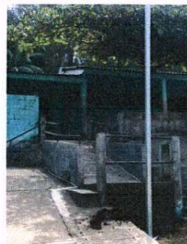
Foto 2: Sustitucion de baranda
