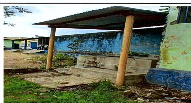
Foto 6: Sustitución de techo
