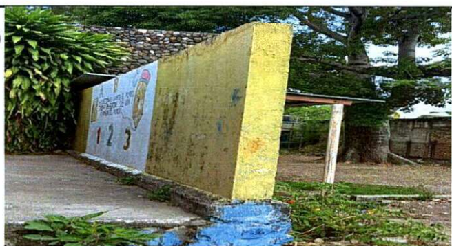
Foto 5: Mejoramiento con piso cerámico
