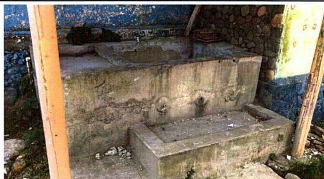
Foto 2: Remoción de área de pila de concreto
