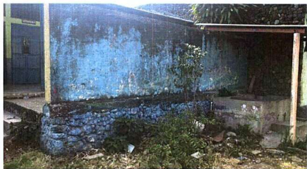
Foto 1: Remoción completa de área de cocina
