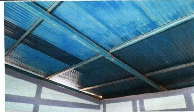
Foto 4: Sustitución de Techo de lamina acanadada por lámina troquelada aluzinc calibre 26
