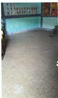
Foto 1: en esta área se realizara sustitucion de piso por piso ceramico.
