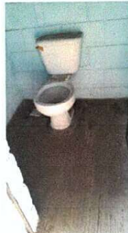
Foto 2: susticion de Inhodoros y romcion de modulos
