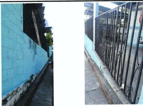
Foto 3: Mantenimiento de barandas
