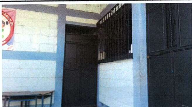
Foto 5: Ampliacion y remoción de aula
