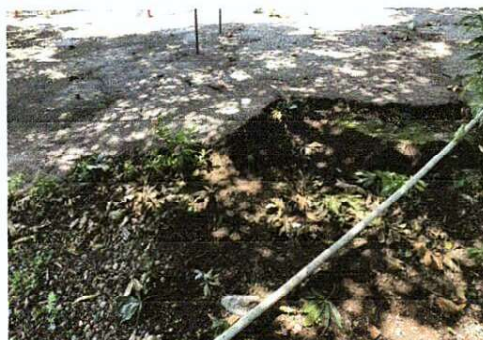
Foto 4: Susticución de planchas de Concreto
