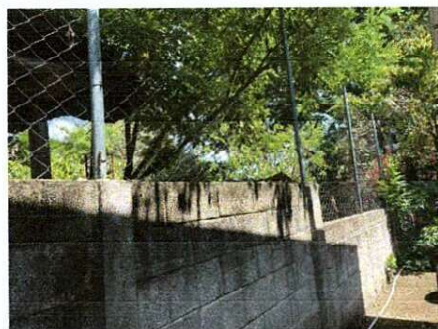
Foto 5: Continuación de Muro Perimetral
