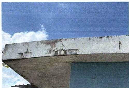
Foto 1: Demolición de Terraza
