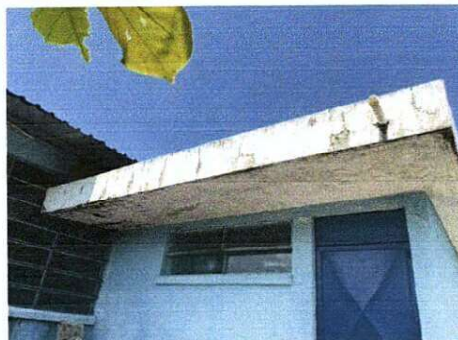
Foto 2: Sustitución de Terraza por lámina
