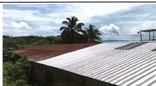
Foto 6: Sustrucción de lamina
