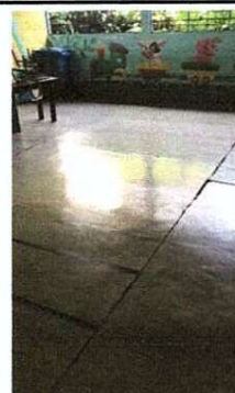
Foto 4: Sustrucción de piso ceramico
