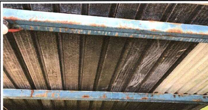
Foto 2: Mantenimiento de estructura de soporte
