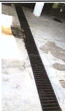
Foto1: Sustrucción de drenaje pruvial
