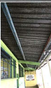
Foto 3: Sustrucción de lamina troquelada por lamina troquelada
