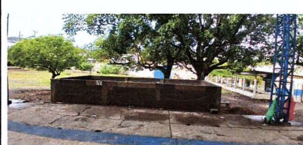
Foto 6: Mantenimiento de patio
