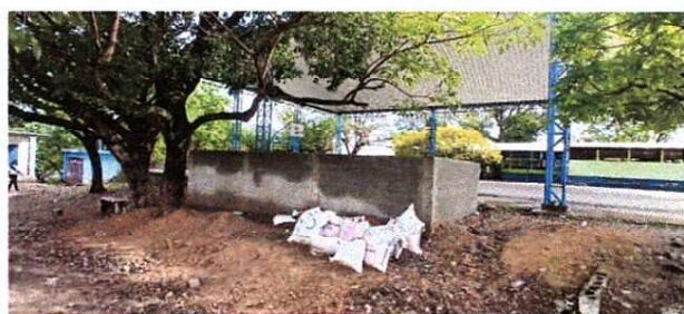
Foto 5: Mejoramiento de patio
