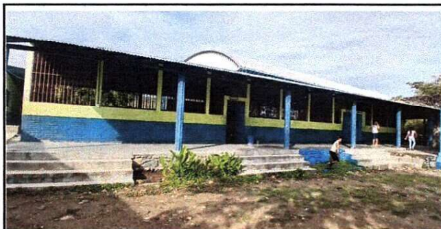
Foto 3: Mantenimiento de balcones
