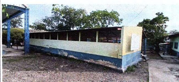
Foto 2: Pintura de paredes externas
