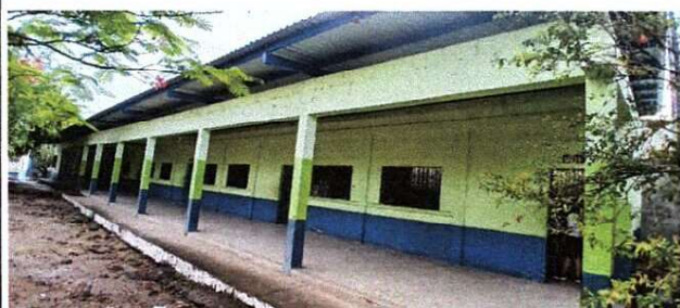
Foto1: Pintura de paredes externas
