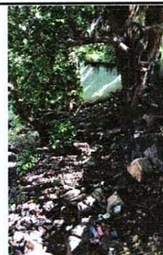
Foto 4: Continucion de muro perimetral trasero
