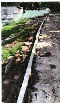
Foto1: Continucion de muro perimetral frontal
