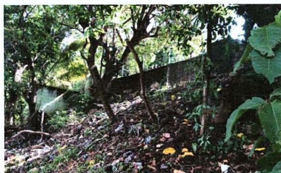
Foto 2: Continucion de muro perimetral trasero
