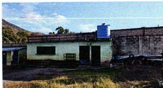
Foto 2: PINTURA Y CAMBIO DE TECHO DE MODULO DE COCINA
