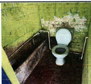
Foto 5: CAMBIO DE SANITARIOS Y MINGITORIOS
