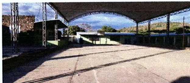
Foto 4: PINTURA GENERAL EN EXTERIOR DE AULAS
