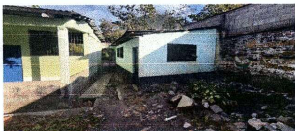
CAMBIO DE LAMINA Y ESTRUCTURA PARA BODEGA
