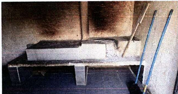
Foto1: REPARACION DE ESTUFA RURAL Y CHIMenea
