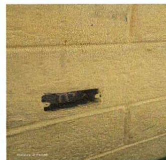
Foto 6: falta de accesorios electricos, mejorar las instalaciones electricas
