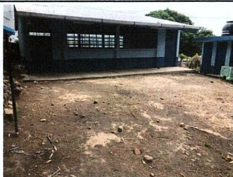
Foto 3: Sustitucion de planchas de concreto
