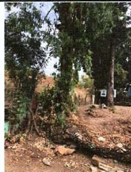
Foto 4: Remocion de muro perimetral
