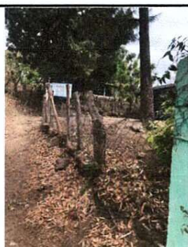
Foto 5: Remocion de muro perimetral
