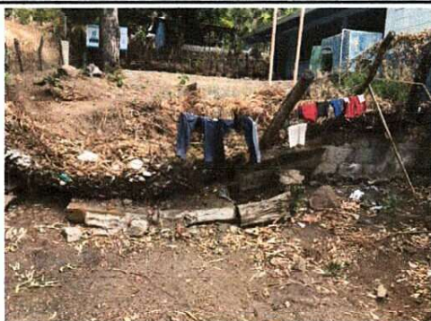
Foto 1: Remocion de muro perimetral
