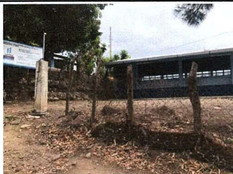
Foto 2: remocion de porton de ingreso
