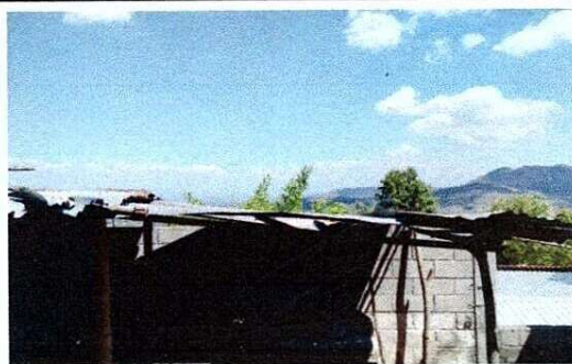
Foto 6: Sustitucion de techo de estructura
