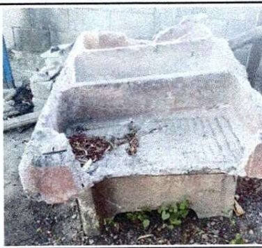
Foto 2: Sustitucion de Pila
