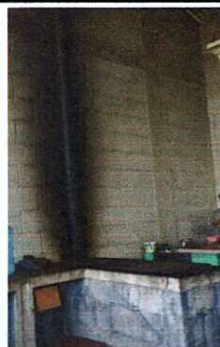
Foto 6: SUSTITUCION DE ESTUFA RURAL COMPLETA
