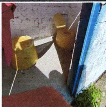
Foto 3: SUSTITUCIÓN DE INODOROS
