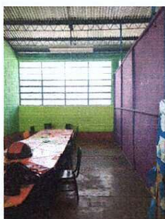
Foto 11: MEJORAMIENTO DE MURO EN MÓDULO
