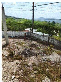
Foto 1: MEJORAMIENTO DE MURO PERIMETRAL
