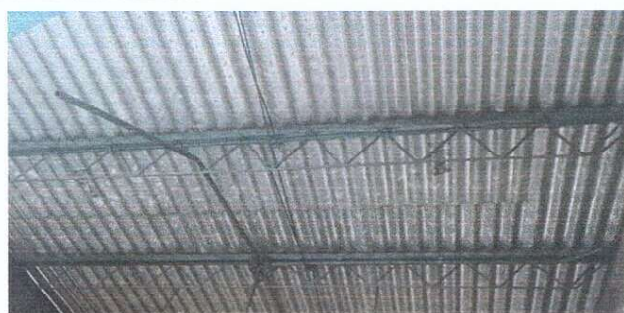
Foto 8: MEJORAMIENTO DE LÁMINA ALUZINC CALIBRE 26
