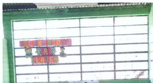
Foto 10: MEJORAMIENTO DE VENTANA EN MÓDULO
