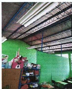
Foto 7: SUSTITUCIÓN DE SISTEMA ELECTRICO, FUERZA E ILUMINACIÓN
