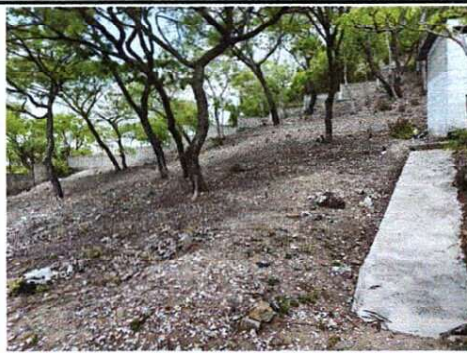
Foto 4: MEJORAMIENTO DE DRENAJE A ACOMETIDA CANDELA DE CALLE
