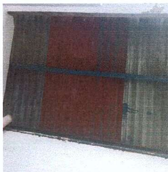
Foto 9: MEJORAMIENTO DE ESTRUCTURA DE TECHO
