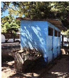
Foto1: Se realizara mejora en muros de servicios sanitarios , sustitucion y mejora de los techos y mantenimiento de puertas.
