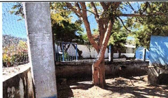
Foto 2: Reparacion y mejoramiento de muro perimetral de block
