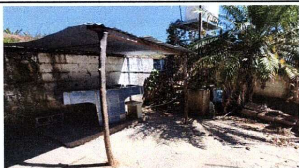
Foto 3: Sustitucion de Pila y Mejoramiento de Estructura para techo y lamina troquelada aluzinc
