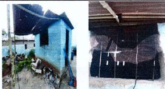
Foto 5: MEJORAMIENTO DE MURO EN COCINA, SUSTITUCIÓN DE ESTRUCTURA DE TECHO METAL POR METAL, MADERA POR METAL, SUSTITUCIÓN DE LÁMINA POR LÁMINA TROQUELADA ALUZINC, VENTANA Y PUERTA DE METAL.
