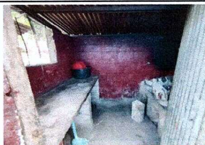
Foto 4: MEJORAMIENTO DE MUEBLE DE COCINA
