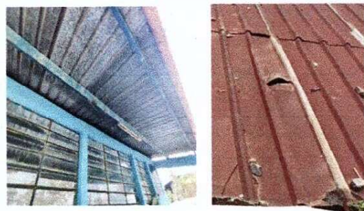
Foto 2: MANTENIMIENTO DE ESTRUCTURA DE TECHO Y SUSTITUCIÓN DE LÁMINA POR LÁMINA TROQUELADA ALUZINC
