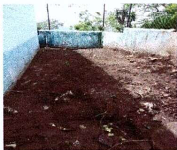
Foto 1: MEJORAMIENTO Y REPARACIÓN DE MURO PERIMETRAL
