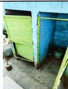
Foto 6: SUSTITUCIÓN DE INODOROS (reparación y mantenimiento de puertas)
