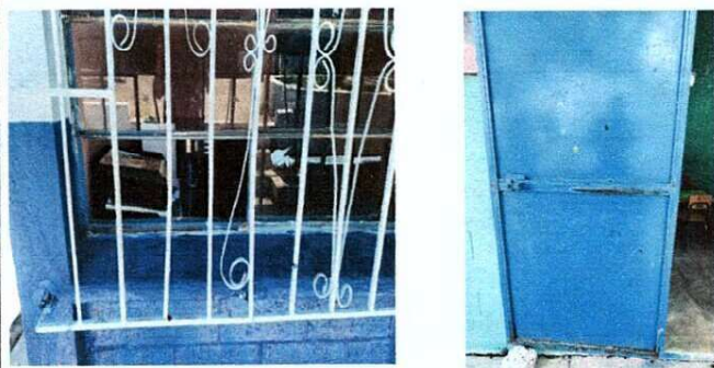
Foto 3: FABRICACION E INSTALACION DE VALCON DE METAL MAS VENTANA PVC MAS INSTALACION DE PUERTA DE METAL
