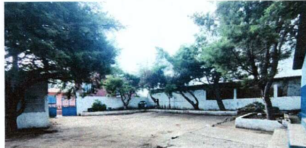
Foto 6: MEJORAMIENTO DE PISO DE CONCRETO
