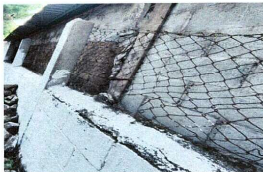
Foto 2: MEJORMIENTO DE MURO EN MODULO
