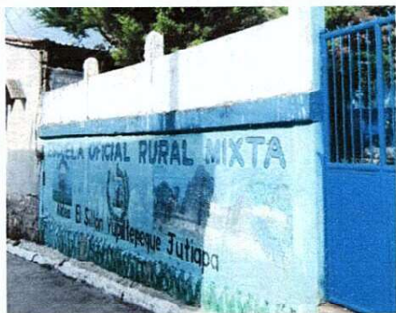
Foto1: MEJORAMIENTO Y REPARACIÓN DE MURO PERIMETRAL DE BLOCK
