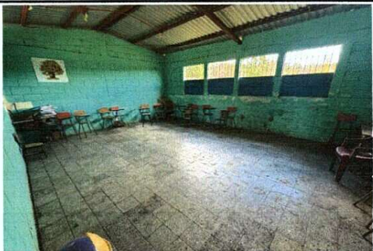
Foto1: MODULO DE AULAS NECESIDAD: INSTALACIÓN DE PISO CERÁMICO.
