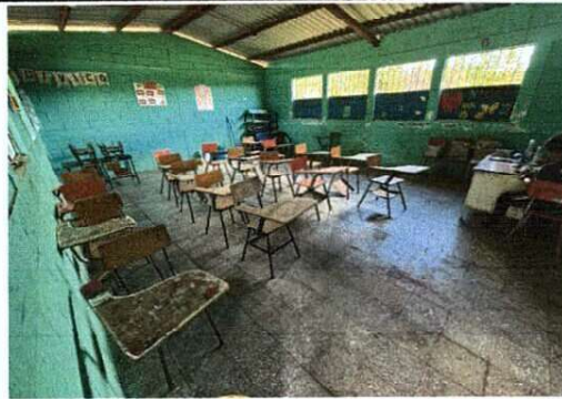
Foto 2: MODULO DE AULAS NECESIDAD: INSTALACIÓN DE PISO CERÁMICO.
