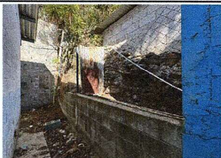
Foto 5: CONTINUIDAD DEL MURO PERIMETRAL PARA MAYOR SEGURIDAD
