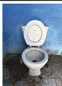
Foto2: SUSTITUCIÓN DEL KIT DE INSTALACION DE LOS SERVICIOS SANITARIOS
