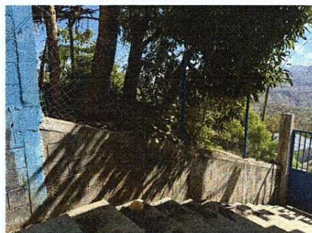
Foto 4: CONTINUIDAD DEL MURO PERIMETRAL PARA MAYOR SEGURIDAD
