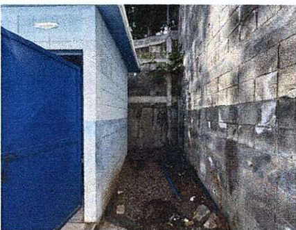
Foto 3: MODULO DE SANITARIOS NECESIDAD: FUNDICIÓN DE CONTRAPISO, INSTALACION DE PILA CON CONEXIÓN DE AGUA Y DRENAJE
