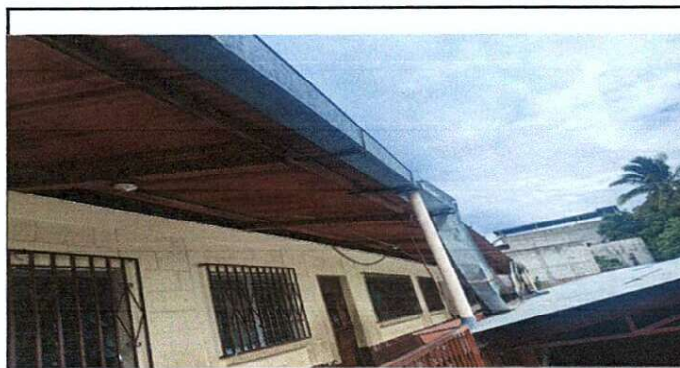
Foto 4: REPARACION DE CANALES DE BAJADA DE AGUS PLUVIALES
