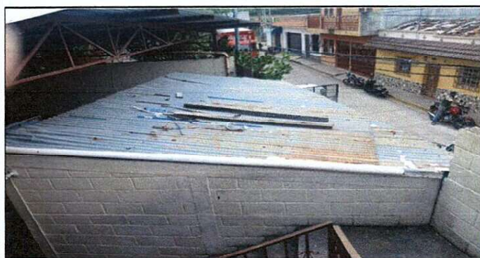
Foto 3: REPARACION DE TECHO AREA DE DIRECCION
