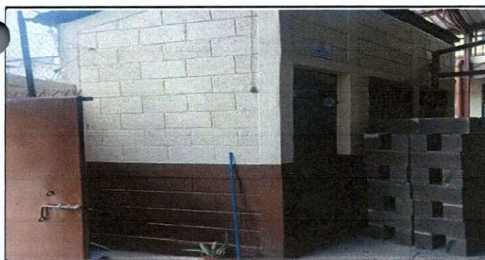
Foto 5: REPARACION, REPELLO Y PINTURA PARED
