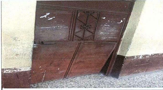
Foto 2: REPARACION DE PUERTAS AREA SALONES DE CLASE
