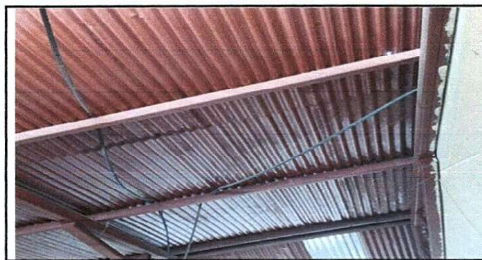
Foto 6: SUSTITUCION DE SISTEMA ELECTRICO
