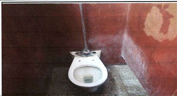
Foto 1: REPARACION DE SERVICIOS SANITARIOS
