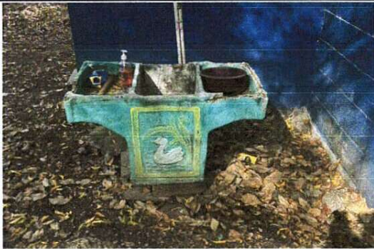
Foto1: Reparación de Cocina, Sustitución de pila de cemento de 2 lavaderos
