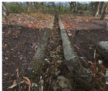
Foto 4: Cuneta de Concreto
