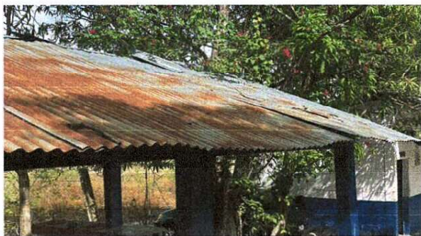
Foto 1: Cubierta de lamina.
