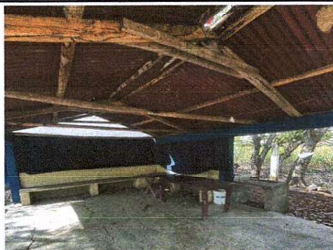
Foto 2: Estructura de techo
