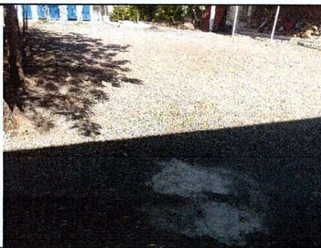
Foto 5: Losa de Patios
