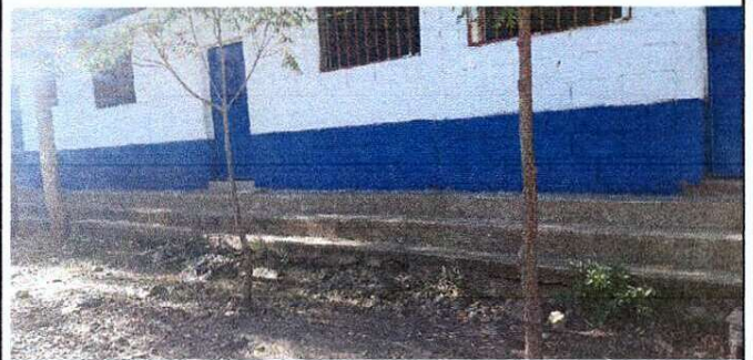
Foto 2: Cuneta de Concreto
