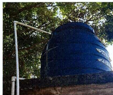
Foto 6: Reparación y mantenimiento de cisterna
