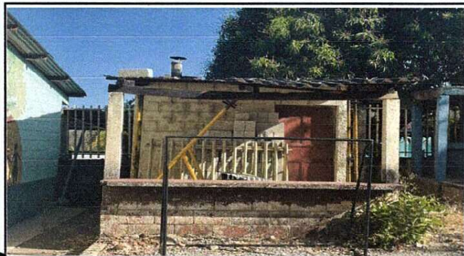
Foto 1: Cubierta de lamina
