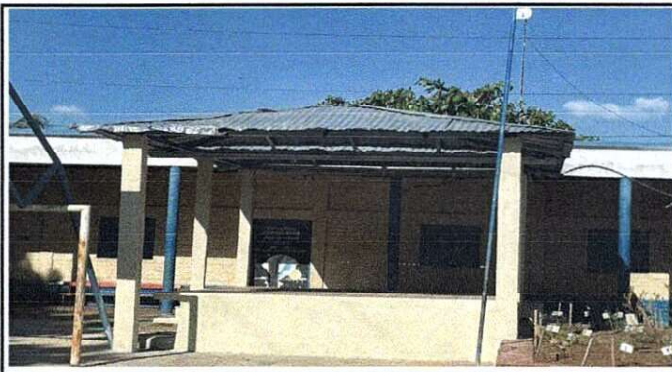
Foto 2: Estructura de Techo
