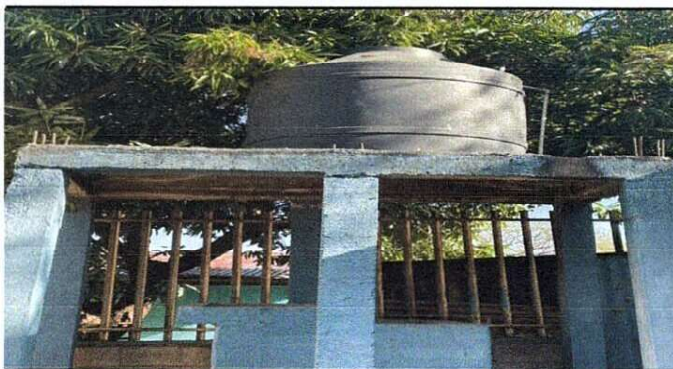
Foto 3: Reparación de depósito de Agua
