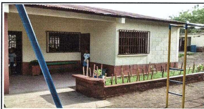
Foto 6: Reparación de puerta y ventana
