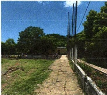
Foto 3: sustitucion de losas de patio
