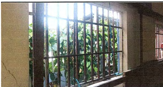
Foto 6: REPARACIÓN DE BALCONES Y SUSTITUCIÓN DE MAYA O VIDRIOS DE LOS NUEVE VENTANALES DE LAS AULAS DE PRIMERO, SEGUNDO Y TERCERO BÁSICO
