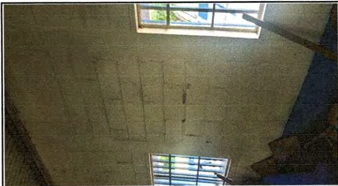
Foto 13 SUSTITUCIÓN DE PINTURA DE INTERIORES DE LAS AULAS DE PRIMERO, SEGUNDO Y TERCERO BÁSICO :
