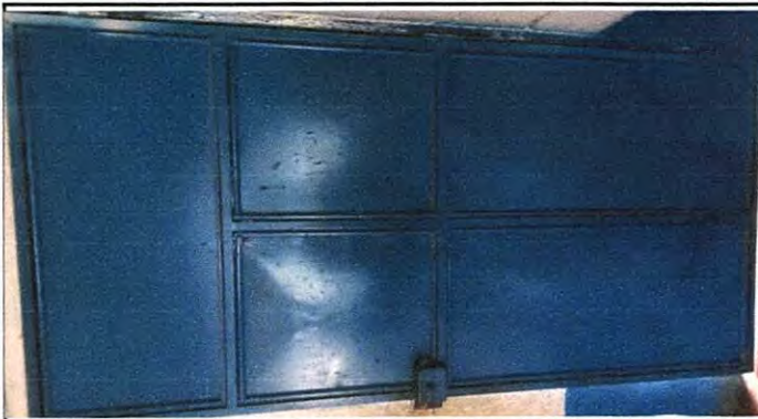
Foto 2: REPARACIÓN DE LA PUERTA DEL AULA DE TERCERO BÁSICO
