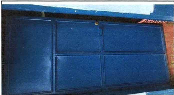
Foto 1: REPARACIÓN DE LA PUERTA DEL AULA DE SEGUNDO BÁSICO
