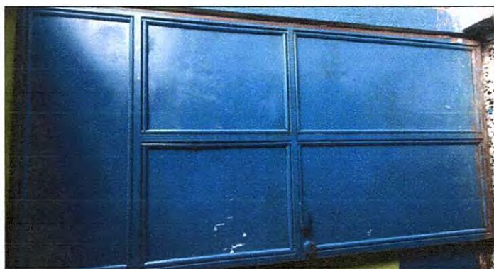
Foto 3: REPARACIÓN DE LA PUERTA DEL AULA DE PRIMERO BÁSICO
