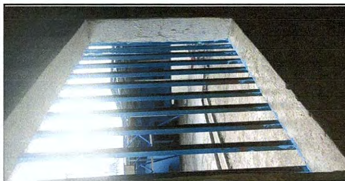
Foto 5: SUSTITUCIÓN DE LAS DOS VENTANAS DEL AULA DE PRIMERO BÁSICO
