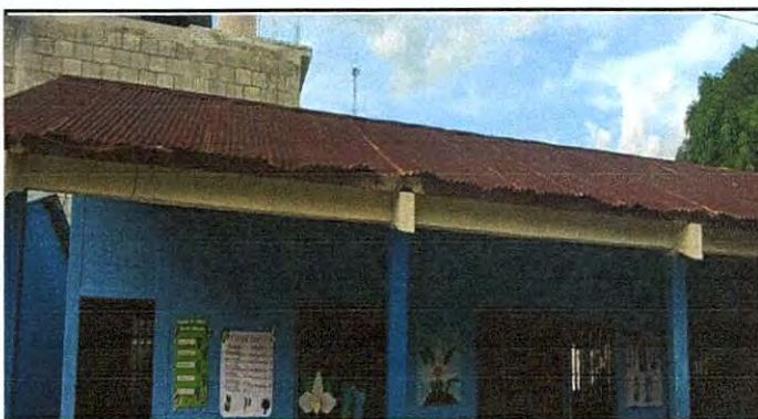
Foto 4: REPARACIÓN DEL TECHO DE LAMINA DE LAS AULAS DE SEGUNDO Y TERCERO BÁSICO
