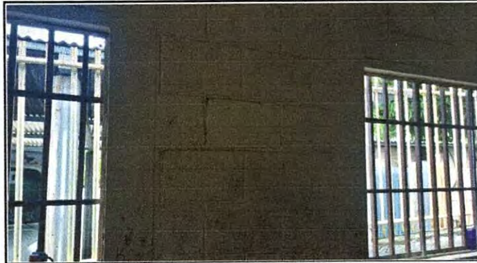
Foto 14 SUSTITUCIÓN DE PINTURA DE INTERIORES DE LAS AULAS DE PRIMERO, SEGUNDO Y TERCERO BÁSICO :
