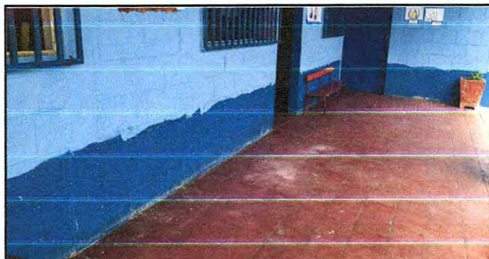
Foto 12: SUSTITUCIÓN DE PINTURA DE PARED Y ZOCALO DE LAS AULAS DE PRIMERO, SEGUNDO Y TERCERO BÁSICO.
