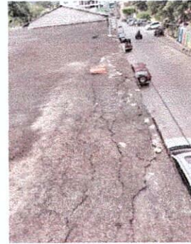
Foto 2: Impermeabilización de losa.
