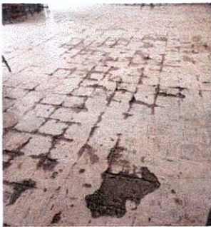
Foto 3: Sustitución de Piso.
