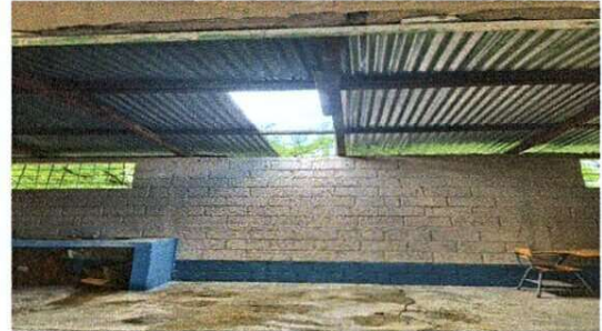
Foto 2: Estructura de techo
