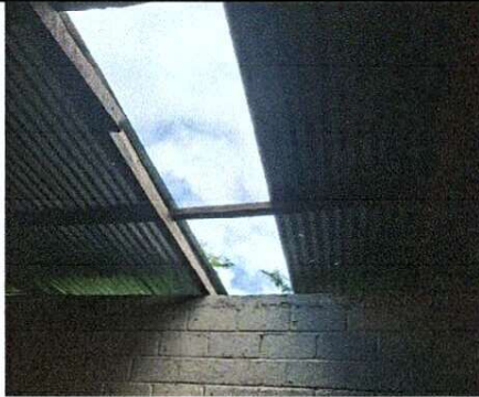
Foto1: cubierta de lamina
