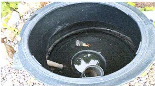
Foto 6: reparación de cisterna
