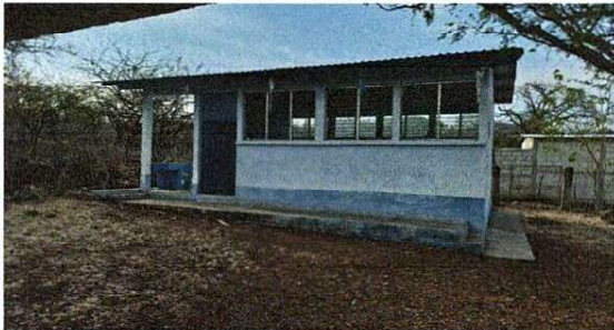
Foto 3: pintura de muros exteriores e interiores
