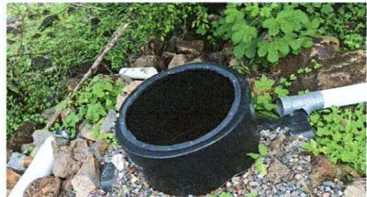
Foto 4: Reparación de drenaje
