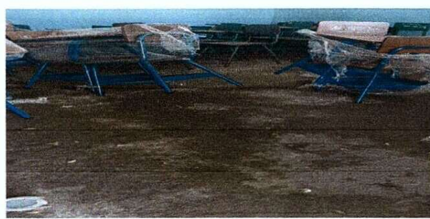
Foto 4: PISO, Sustitución de piso de granito
