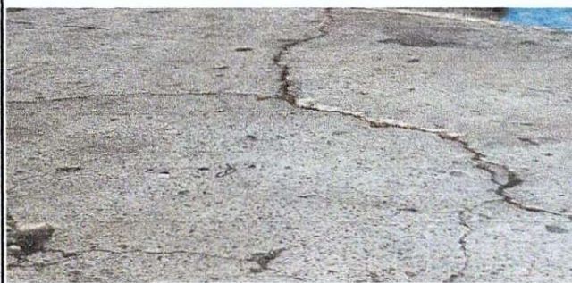
Foto 3: PISO, Sustitución de piso de granito
