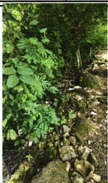
Foto1: Mantenimiento De muro de Contencion
