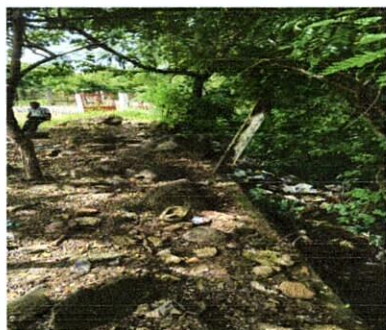
Foto3: Mantenimiento De muro de Contencion
