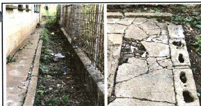
Foto 5: Reparación de cuneta y banqueta de concreto
