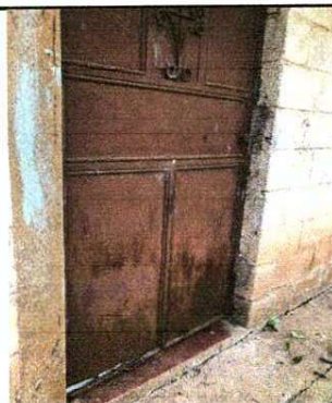
Foto 4: Sustitución de puerta en mal estado
