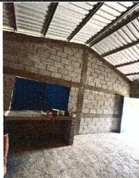
FOTO 1: PARED SIN ACABADO Y CON HUMEDAD Y ALEROS ABIERTOS
