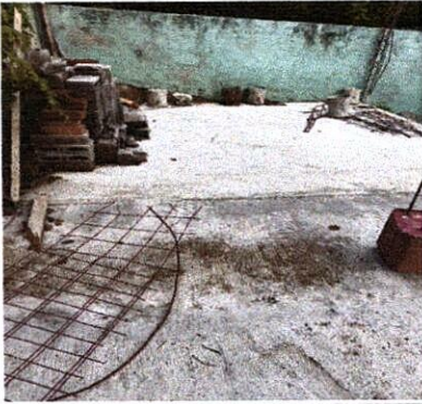
FOTO 1: TORTA DE CEMENTO DETERIORADA Y GRETADA
