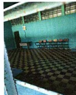
Foto 2: Sustitucion de piso cerámico
