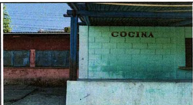
foto: 9 Pintura de exterior de cocina
