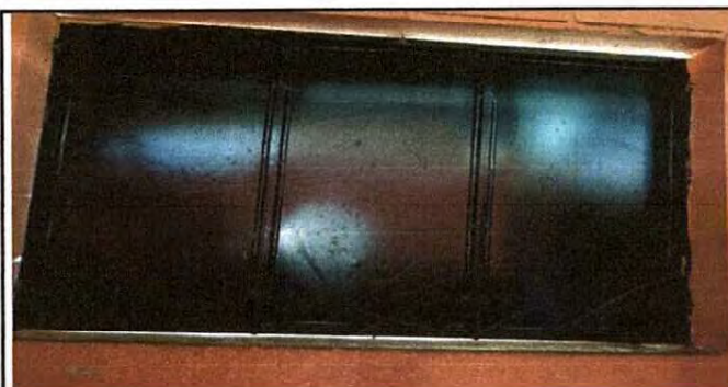
foto: 6 sustitucion de ventana a corrediza
