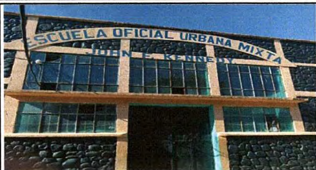
Foto 7: sustitucion de ventanas de vidrio
