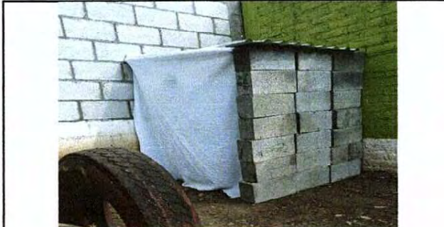
foto: 12 Reparacion de de baños
