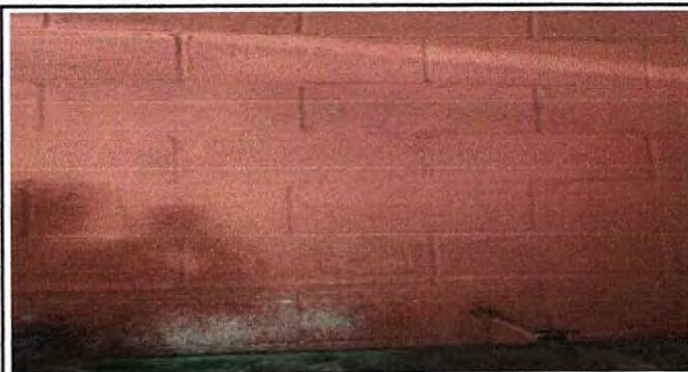
Foto: 8 Pintura de interior de cocina
