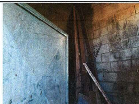
Foto 4: se ampliará la cocina eliminando una pared
