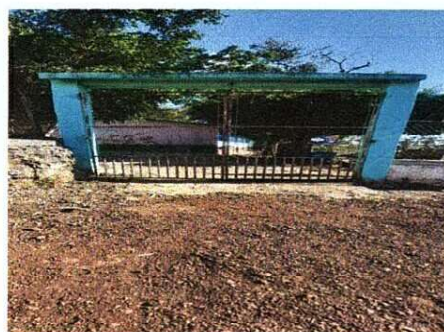
Foto 6: sustitución del portón.
