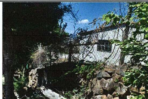
Foto 2: parte de la tela en mal estado se levantará para construir un muro de cemento de piedra y bloques.
