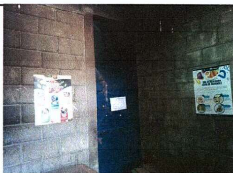
Foto 5: Sustitución de la puerta
