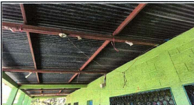
Foto 4: Mantenimiento a estructura de metal de techo en mal estado.
