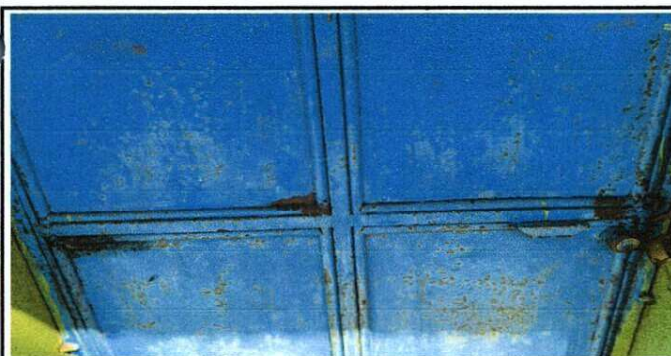
Foto 5: Mantenimiento a puertas de metal en mal estado.
