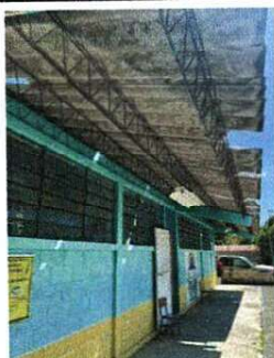
Foto 5: LAMINA DE DURALITA EN MALAS CONDICIONES.
