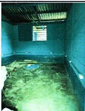
Foto 3: Sustitución de puerta
