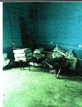
Foto 2: Reparación de cocina,
