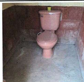
Foto 6: Sustitución de inodoro
