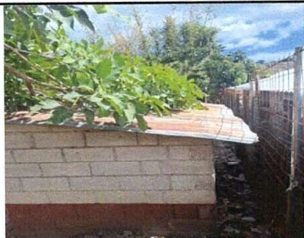
Foto 3: Cambio de Techo
