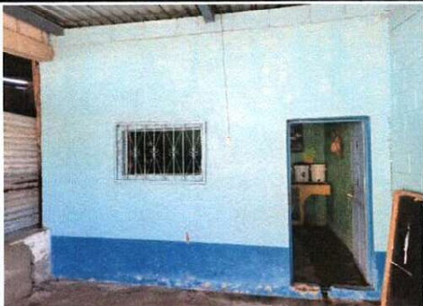
Foto 7: Sustitución de puerta y ventana de cocina
