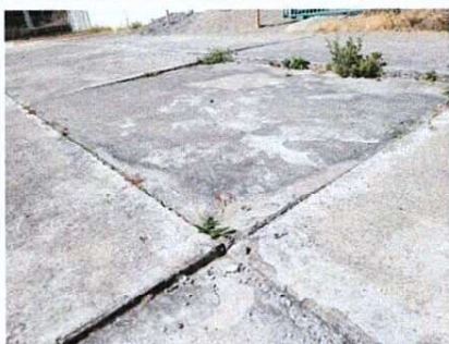
Foto 9: Reparación planchas de concreto patio
