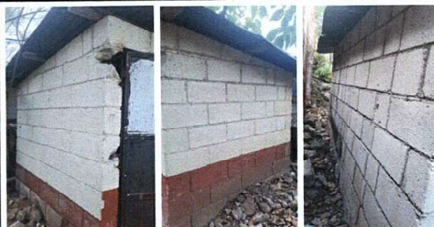
Foto 4: Repello de paredes.
