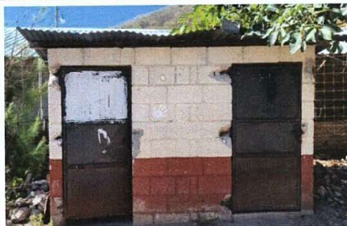
Foto 2: Sustitución de puertas
