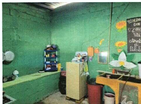
Foto 8: Repello de cocina, sustitución de estufa rural y colocación de piso cerámico en cocina
