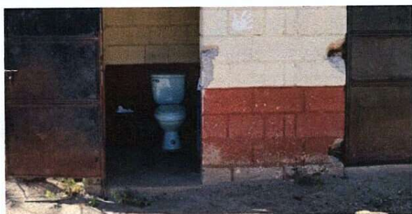
Foto 5: Reparación de red de drenaje y agua potable. Reparación de piso en sanitarios
