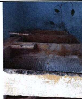
Foto 4: Sustrucción pila de cemento.
