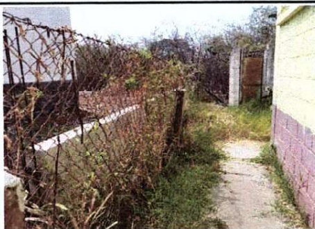
Foto 5: Reparación de muro perimetral de block
