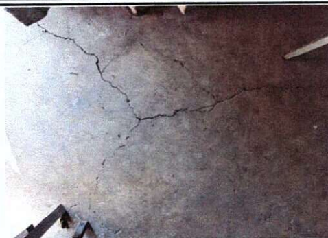
Foto 2: Sustrucción torta de concreto.
