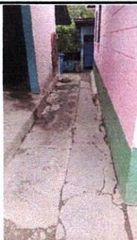
FOTO 5: REPARACIÓN DE RED DRENAJE Y RED DE AGUA POTABLE (SE ENCUENTRA TAPADA), Y REPARACIÓN DE BANQUETA DE CONCRETO
