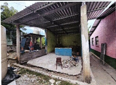
FOTO 7: ESTRUCTURA DE TECHO (SUSTITUCIÓN DE SOPORTE DE METAL POR METAL)
