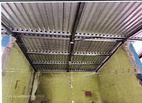
FOTO 9: REPARACIÓN DE SISTEMA ELÉCTRICO
