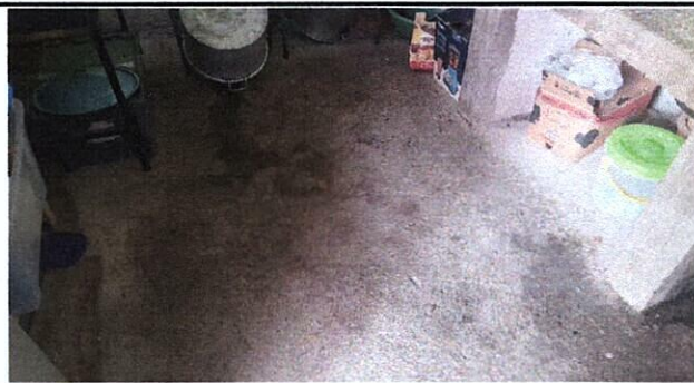
FOTO 6: REPARACIÓN DE TORTA DE CONCRETO
