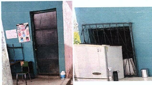
FOTO 8: SUSTITUCIÓN DE PUERTA Y VENTANAS DE COCINA
